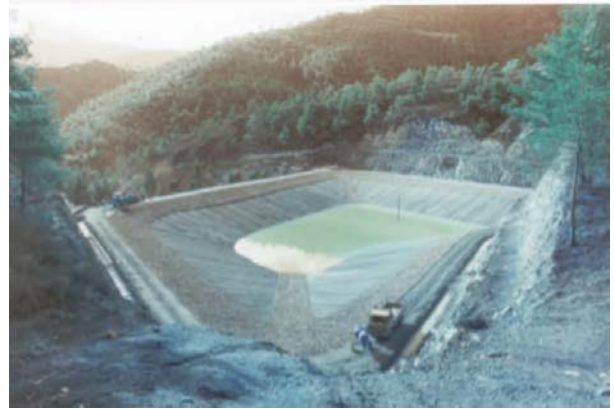
Εικόνα 3. Υπόδειγμα κατασκευής του άνω τεχνητού ταμιευτήρα με οπλισμένο σκυρόδεμα
