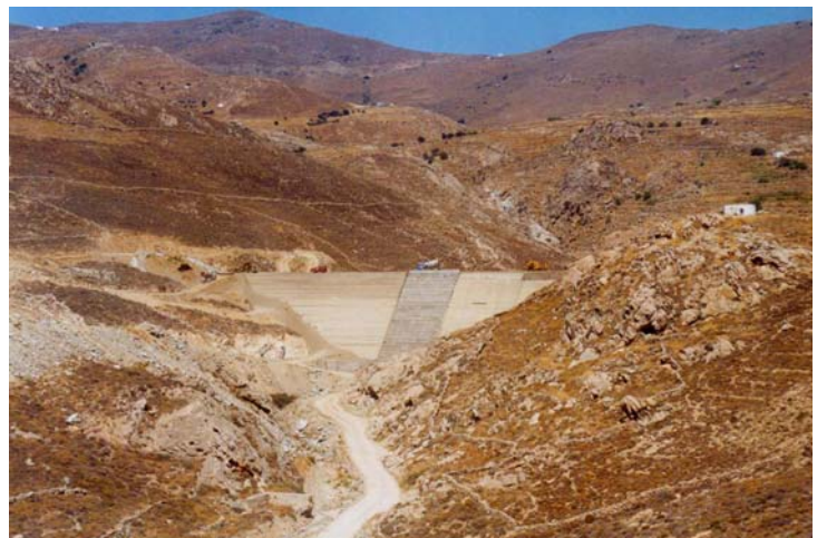
Εικόνα 2. Κατασκευή του φράγματος στη θέση Στενό για τη δημιουργία του κάτω τεχνητού ταμιευτήρα
